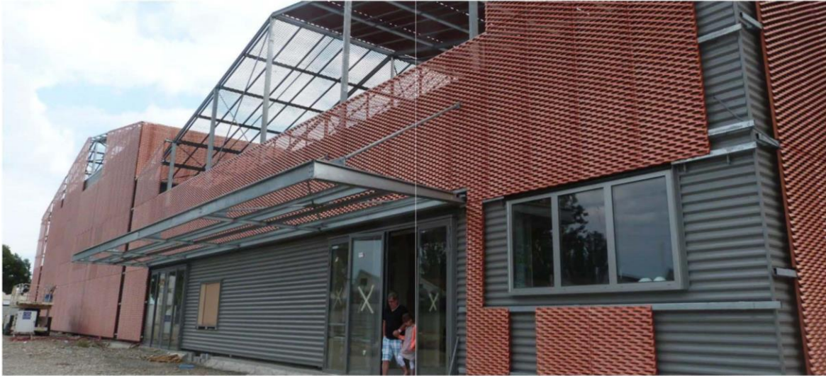
Le Forum, espace de proximité, telle est la vocation de cet équipement qui sera à la fois sportif, événementiel et culturel, qui répond à des critères relevant de Haute qualité environnementale (HQE). L'habillage du bâtiment dans les tons cuivrés a été choisi pour rappeler la couleur des toitures avoisinantes.
