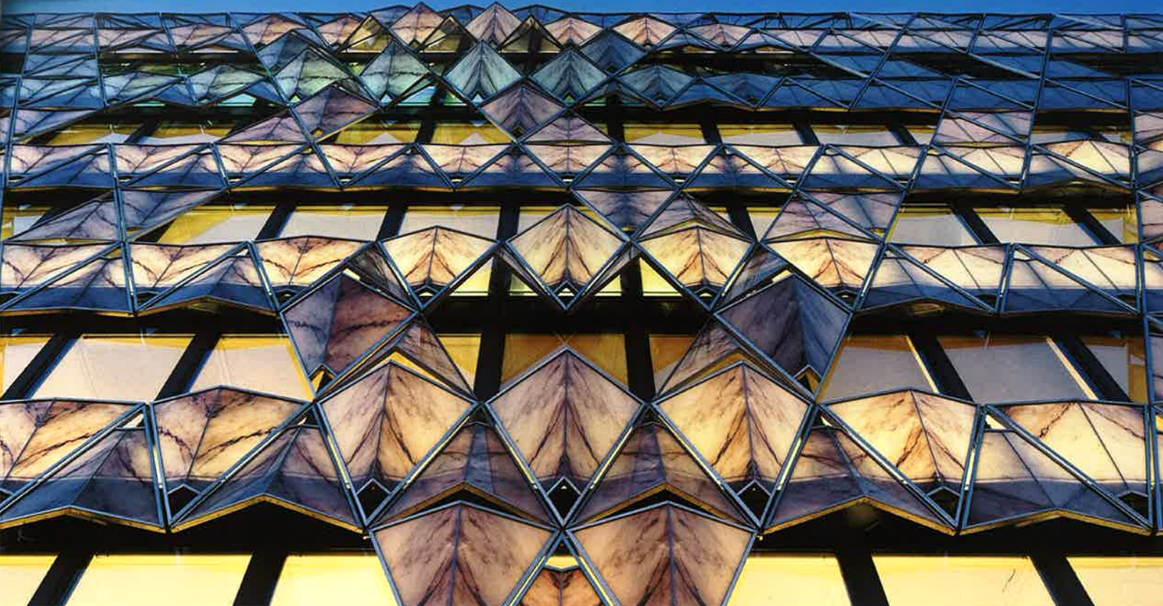
Az épület emblemikus jelképe a főhomlokzat márványmintás, plasztikus burkolata, amely a napfénytől és a belátástól is védi a belső tereket
