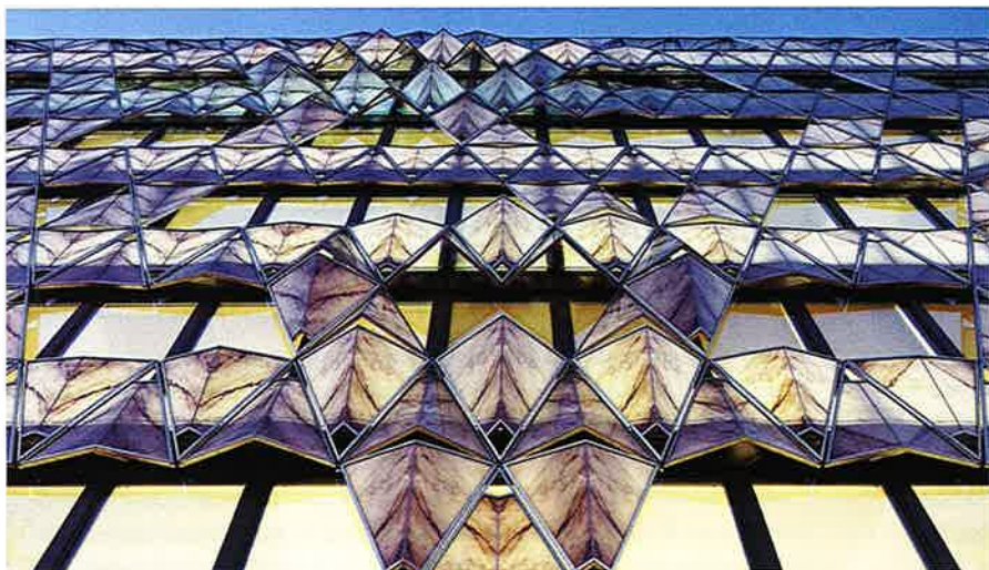
L'origami marbré se décolle progressivement du mur rideau pour créer au centre de la façade un pliage plus serré et saillant.
