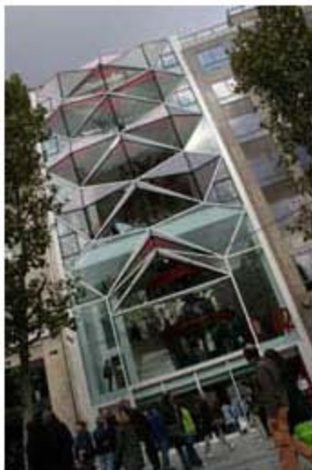
「C42」。シトロエンのマークを全面で表現したファサード
