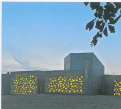
Extension du LAM (Lille Métropole Musée d'art moderne, d'art contemporain et d'art brut, Villeneuve d'Ascq) construite par Manuelle Gautrand, juillet 2010. © Photo : Philippe Ruzat.
