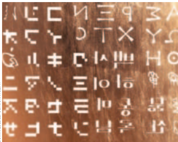
Une partie des mille lettres du moucharabieh typographique en cours de pose.
