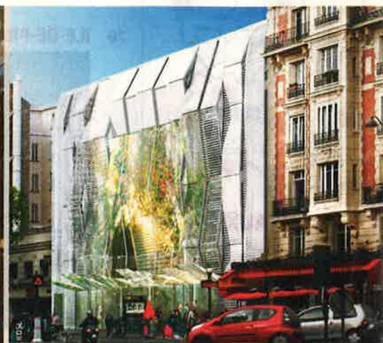
La façade du Gaumont Alésia, côté Général-Leclerc, sera constituée de rubans verticaux vitrés et plissés animés de LED.
