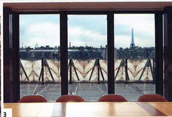
1. Détail de la façade et de ses plaques de verre dans leur sertissage en Inox. 2. Le bâtiment « Origami » dans son contexte urbain, flanqué de deux immeubles. 3. Au dernier niveau, la façade plissée forme un garde-corps devant la terrasse panoramique.
